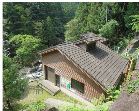
▲新宮市 高田発電所
